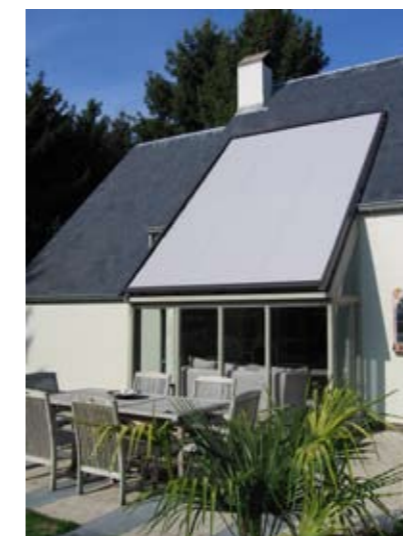
Protection solaire véranda
